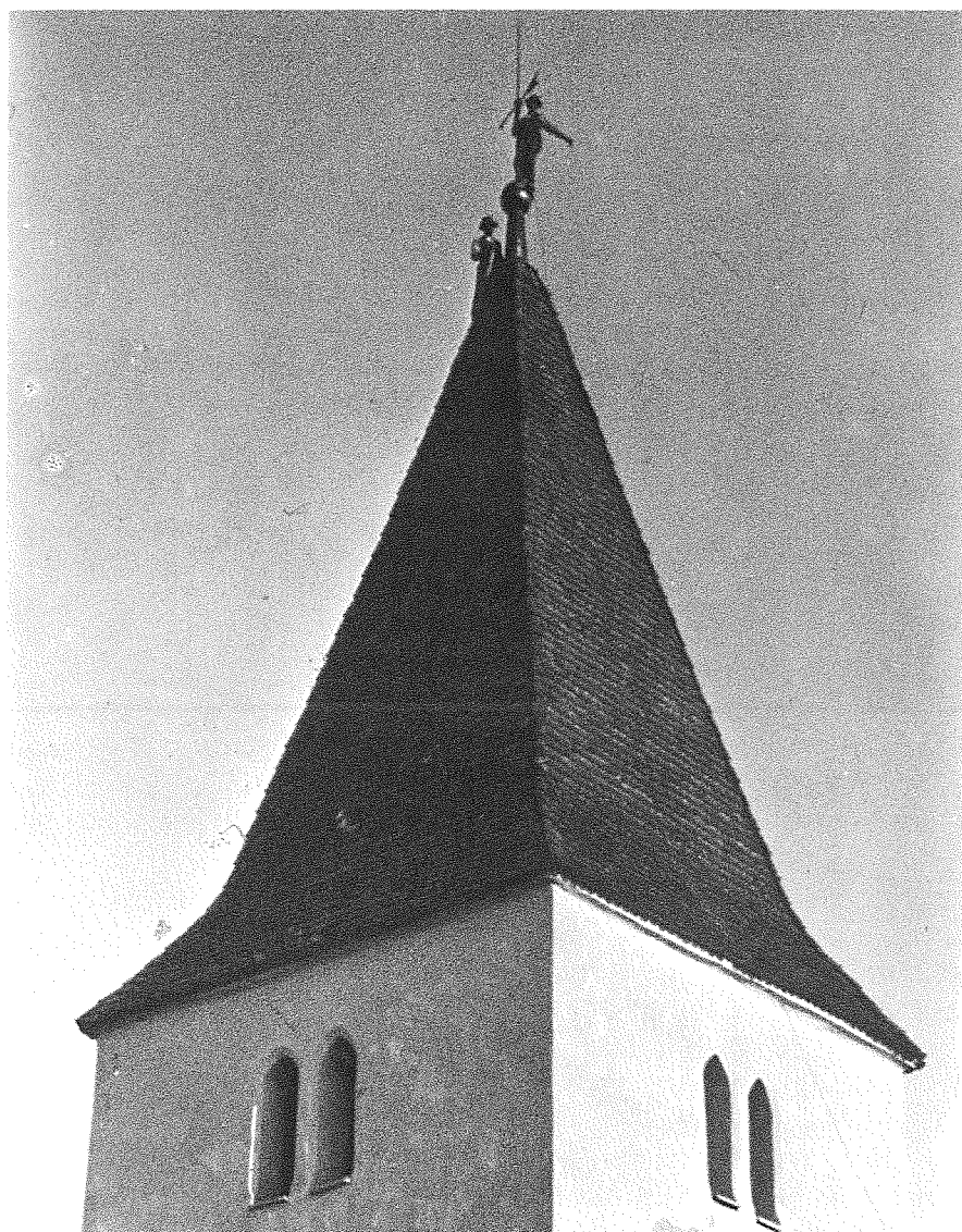
1911 oder 1919, Turmkugel und Wetterpfeil sind soeben neu aufgesetzt.
