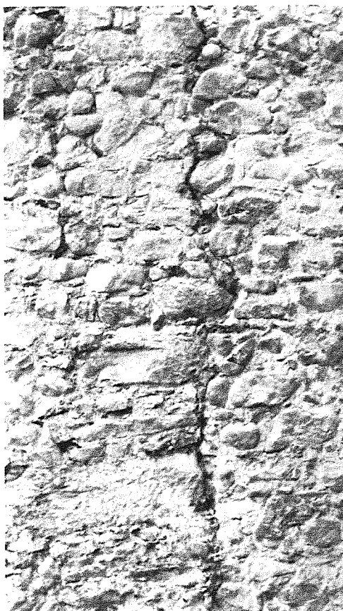
Nordseite des Kirchenschiffes während der Renovation 1985. Die senkrechte Baunaht mar- kiert die Erweiterung des Schif- fes gegen Westen um 1489.
